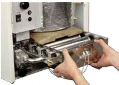
Эта горелка с полным предварительным смешением разработана для оптимального распределения пламени в камере сгорания и теплообменнике. Одноступенчатая горелка работает с оптимальным КПД.
