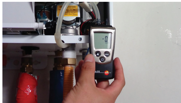
<Измерение давление подаваемого газа>
