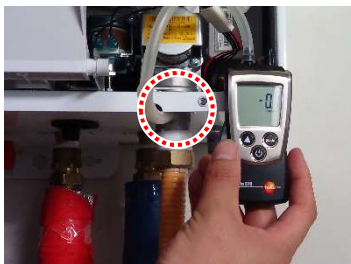
<Измерение давления газа>
